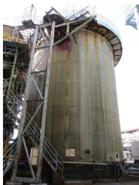
鋼鉄製（耐酸レンガ内張）の硫酸吸収塔（改良前）
